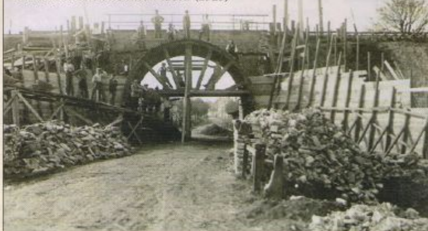
Rozšíření železničního mostu (1929)
