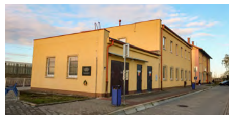
Po rekonstrukci nádraží se pamětní deska ocitla mimo historický kontext. Toto přemístění lze stěží označit za důstojné... Foto: MMG Hustopeče
