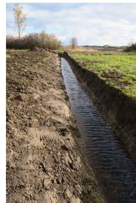
Dokončené pozemní úpravy na korytu a příprava pro výsadbu aleje podél vodního toku směr Hrudý a Obora.
