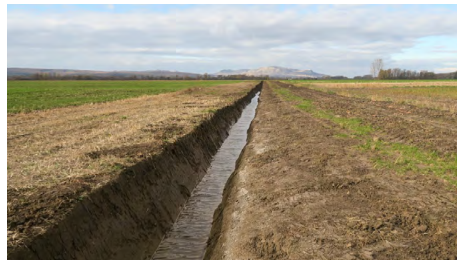
Dokončené pozemní úpravy na korytu a příprava pro výsadbu aleje podél vodního toku směr Přítluky.
