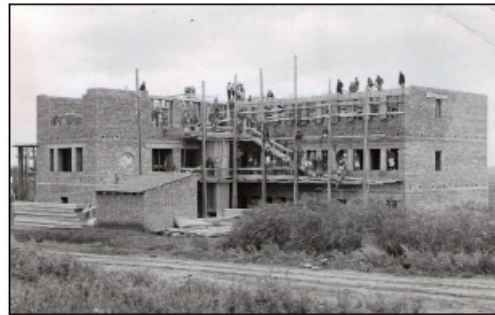
1931 – 32 viděl neuvěřitelné tempo při stavbě školy
