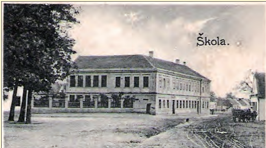
Po přístavbě má střecha obecné školy jiný tvar a okna vlevo jsou vyšší. Přistavěny byly dvě třídy nad sebou a schodiště.
